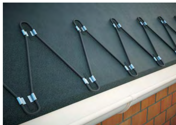
Uchwyty z blachy miedzianej RE-IH-1-CU lub cynkowo-tytanowej RE-IH-1-ZNTI
